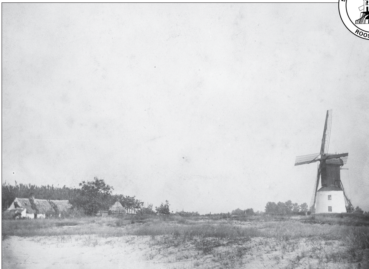
Kleine standaardmolen op torenkot, vermoedelijk in West-Vlaanderen, plaatsnaam onbekend. Collectie: Ton Meesters, Breda.
